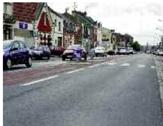
Les différents travaux de voirie permettront d'enterrer les réseaux.
