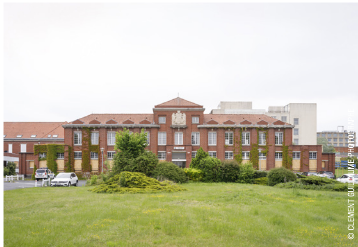
Dans l'axe de l'entrée : le bâtiment de la Direction générale, édifice emblématique du site
