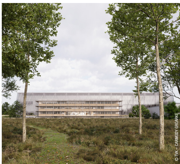
Vue du projet, façade Sud, depuis le plateau, non loin de l'arrivée de la passerelle d'Abbeville
