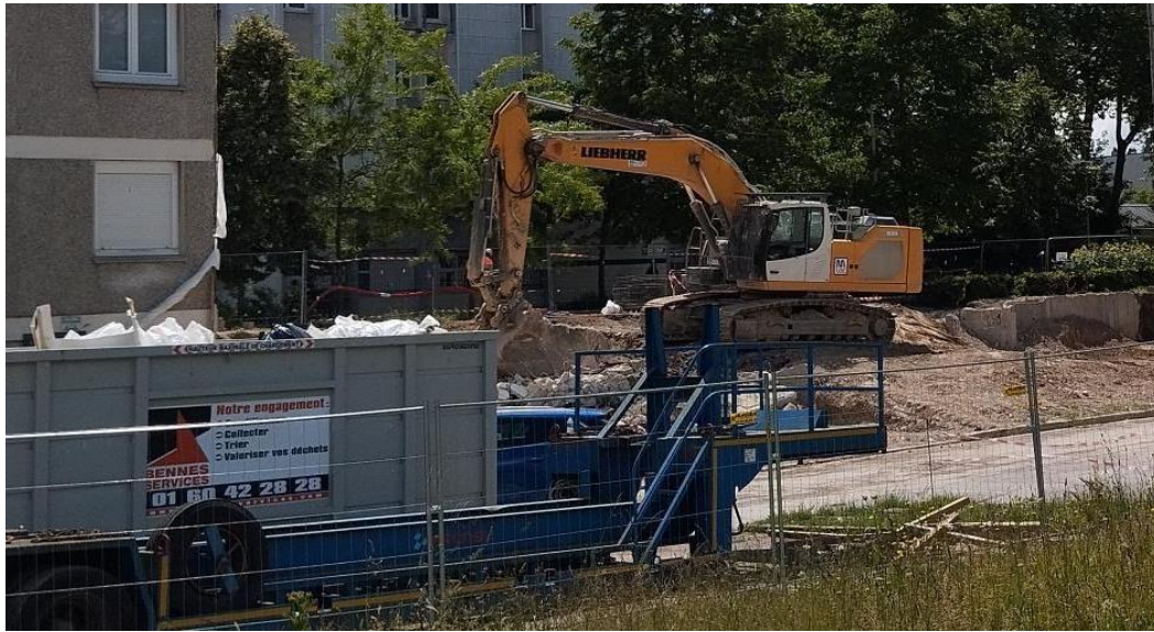
Photo d'illustration : pelle mécanique en cours d'intervention (Etouvie - 2024)
