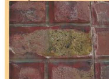
Joints beurrés repassés au fer à joint :
