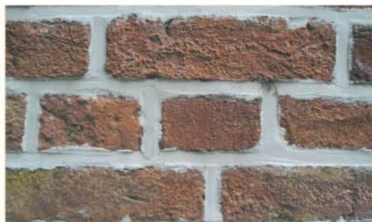
1- La brique de cette maçonnerie a été endommagée : son épiderme est grêlée. Un nettoyage inadapté en est la cause, sans doute un sablage trop agressif.
