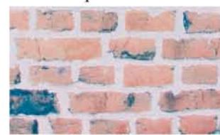
Appareillage endommagé suite à un déjointoiement brutal : brique cassée, joint élargi
