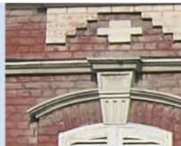
Éliminer les efflorescences superficielles par nettoyage doux.
