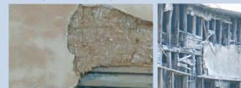
Anciennement, l'enduit de chaux recouvrait une structure légère faite de poutres et de clins de bois.
