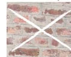
Le rejointoiement au ciment néfaste à la maçonnerie
