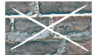
Altération du support par remplacement partiel d'un joint saillant par un mortier de ciment.
