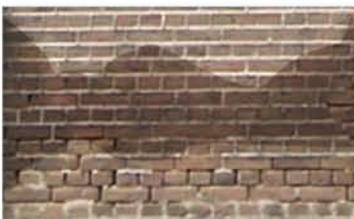
Combattre les infiltrations d'eau dans la maçonnerie en restaurant le joint disparu.
